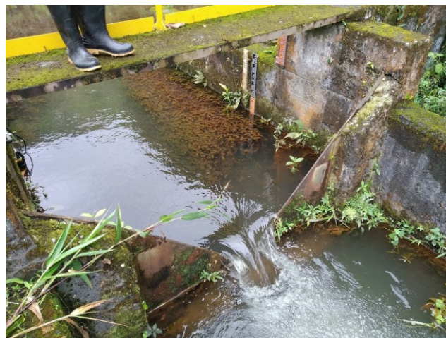
Figura D-3. Vertedero triangular con condiciones de funcionamiento inadecuadas. El nivel aguas abajo alcanza a interferir con la descarga
