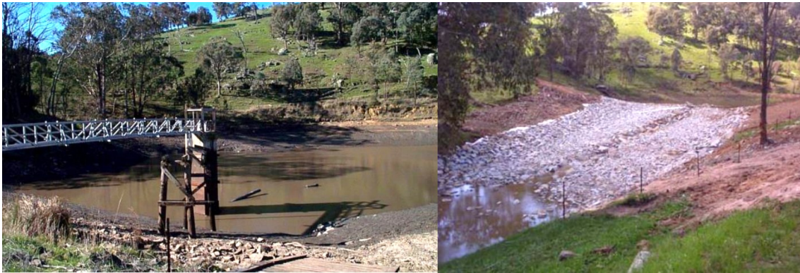
Figura 7-1. Ejemplo de eliminación total del terraplén en Honey Suckle Creek Reservoir (Australia): condición original (izquierda) y posterior a la remoción de la presa (derecha) [ 113, Fig. 6 ].
